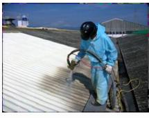
**熱対策** 遮熱塗料を施工し、表面温度を10%低減！
